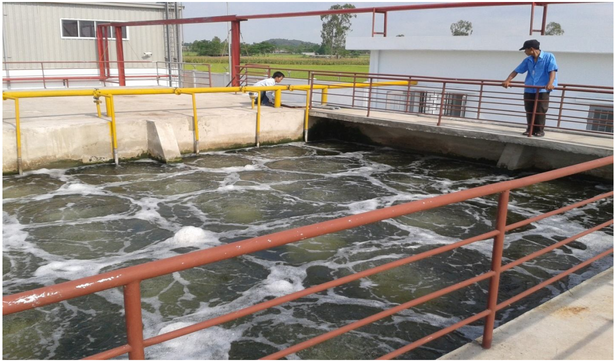
HỆ THỐNG XỬ LÝ NƯỚC THẢI 600M3 NHÀ MÁY MAY NGA SƠN THANH HÓA
