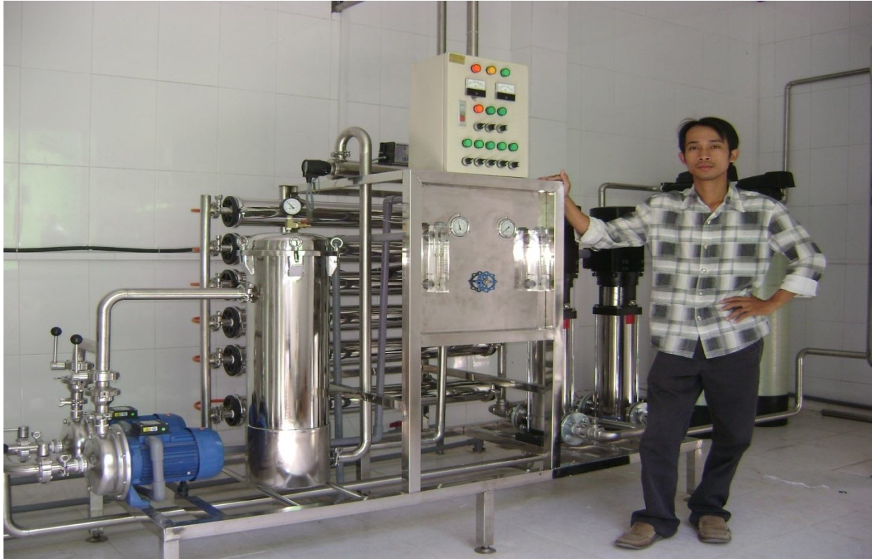
HỆ THỐNG XỬ LÝ NƯỚC RO 2M2H NHÀ MÁY DƯỢC DANAPHA ĐÀ NẴNG
