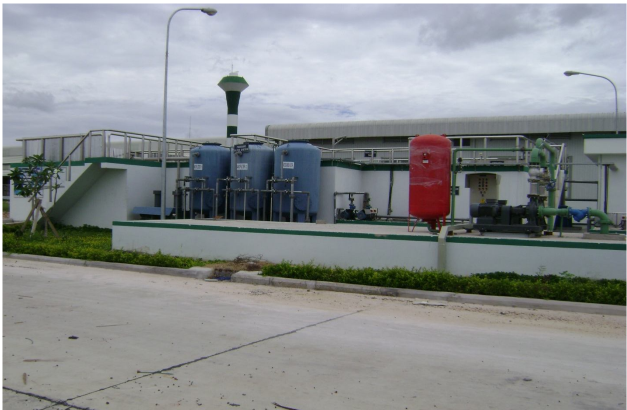
HỆ THỐNG XỬ LÝ NƯỚC THẢI 700M3 TẠI NHÀ MÁY MỘC BÀI TÂY NINH
