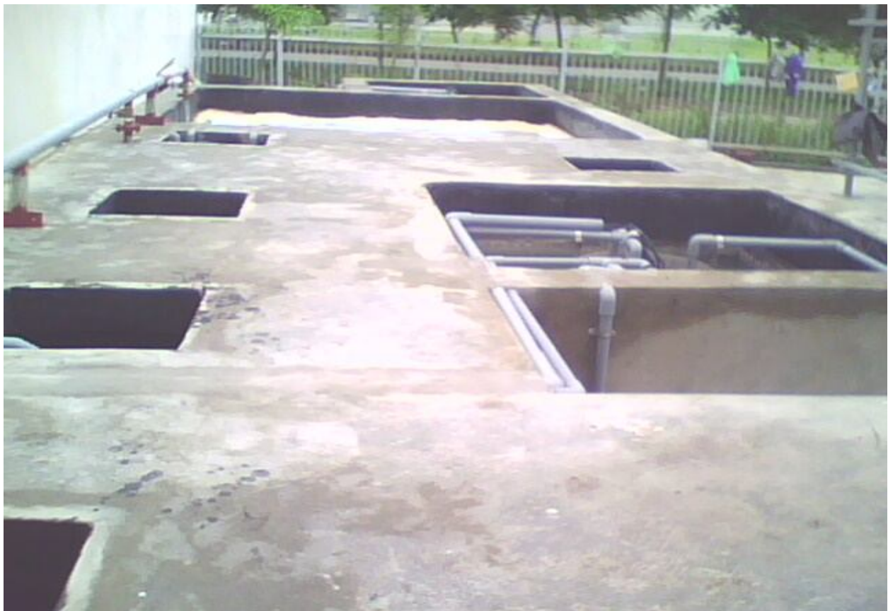
HỆ THỐNG XỬ LÝ NƯỚC THẢI 50M3 NHÀ MÁY DƯỢC HASAN – BÌNH DƯƠNG
