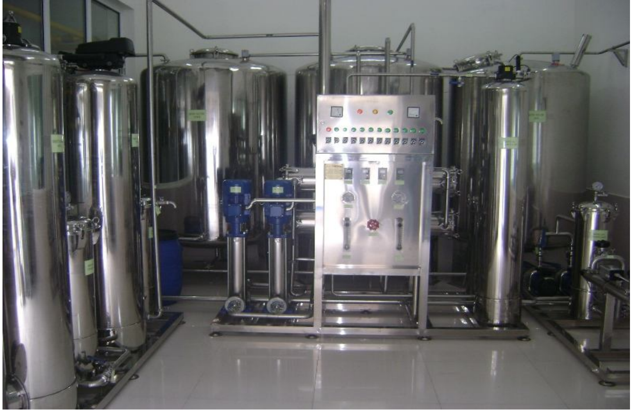
HỆ THỐNG XỬ LÝ NƯỚC RO 2M3H NHÀ MÁY DƯỢC LILI BẮC NINH
