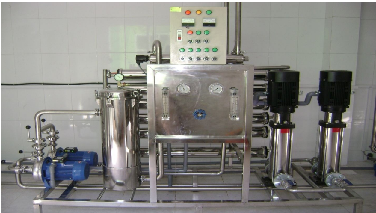
HỆ THỐNG XỬ LÝ NƯỚC RO 2M2H NHÀ MÁY DƯỢC DANAPHA ĐÀ NẴNG
