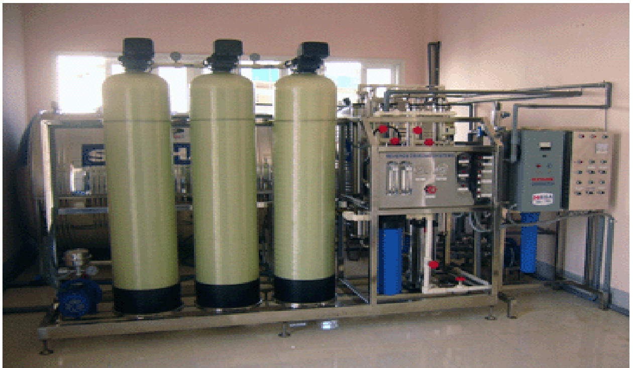
HỆ THỐNG XỬ LÝ NƯỚC RO 3M3H BỆNH VIỆN ĐA KHOA BUÔN MÊ THUẬT
