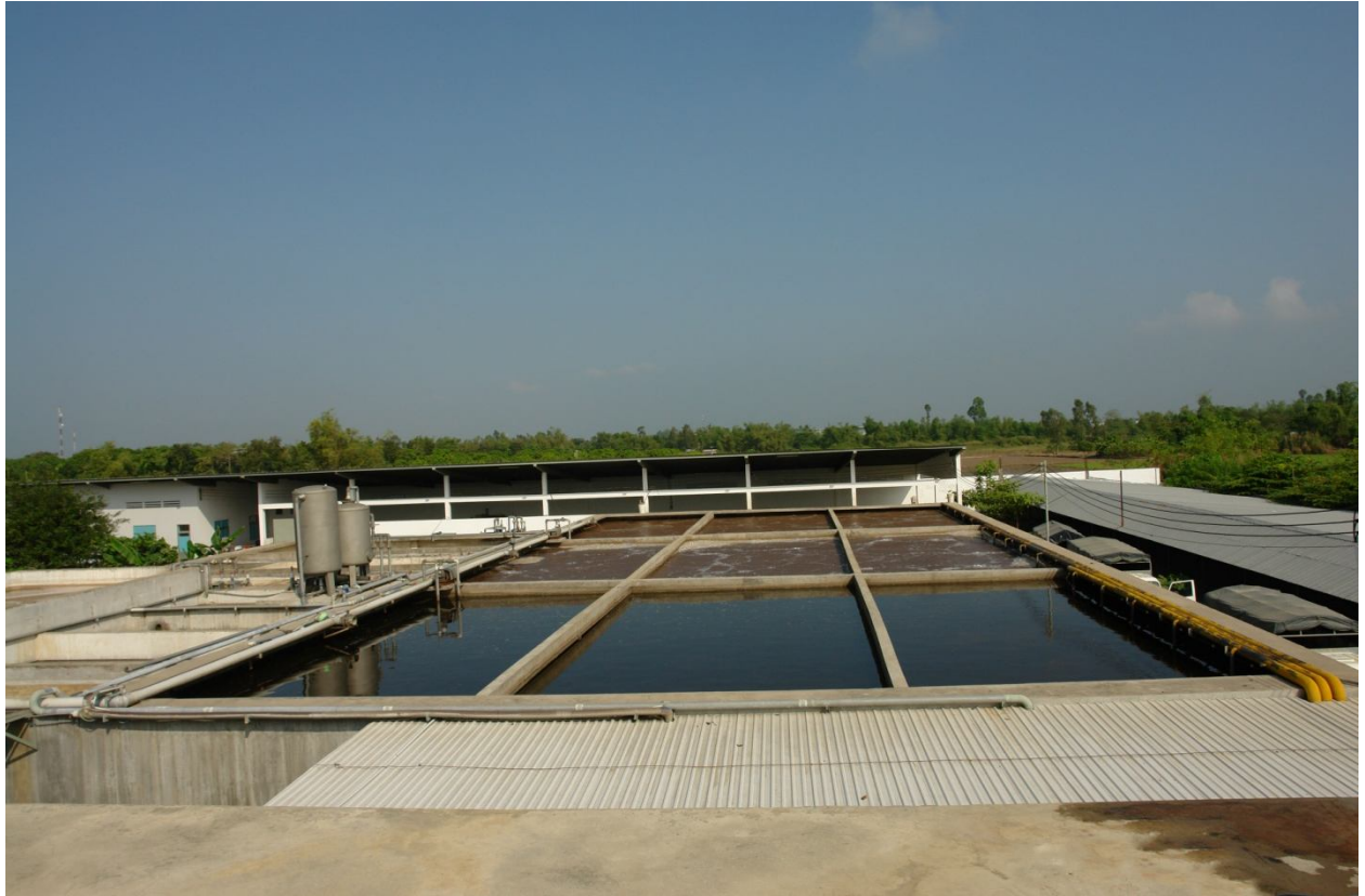
Trạm xử lý nước thải 2.000m 3 /ngày.đêm Công ty Cổ phần Thủy sản NTSF – Cần Thơ
