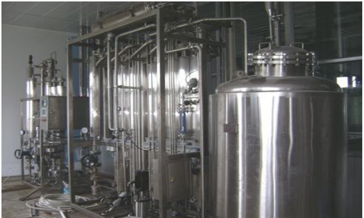
HỆ THỐNG MÁY NƯỚC CẮT VÀ BỒN CHỨA NƯỚC CẮT
