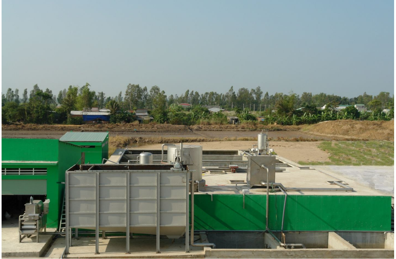
Trạm xử lý nước thải 500m 3 /ngày.đêm Công ty TNHH MTV XNK TS An Pha – Cần Thơ
