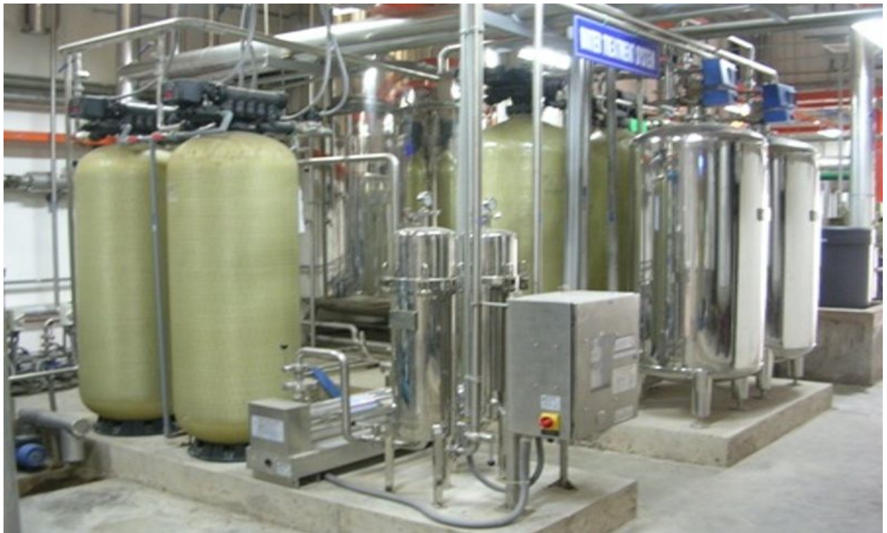
HỆ THỐNG XỬ LÝ NƯỚC RO 2 CẤP CS 3M3H TẠI NHÀ MÁY DƯỢC PHẨM MINH HẢI CÀ MAU
