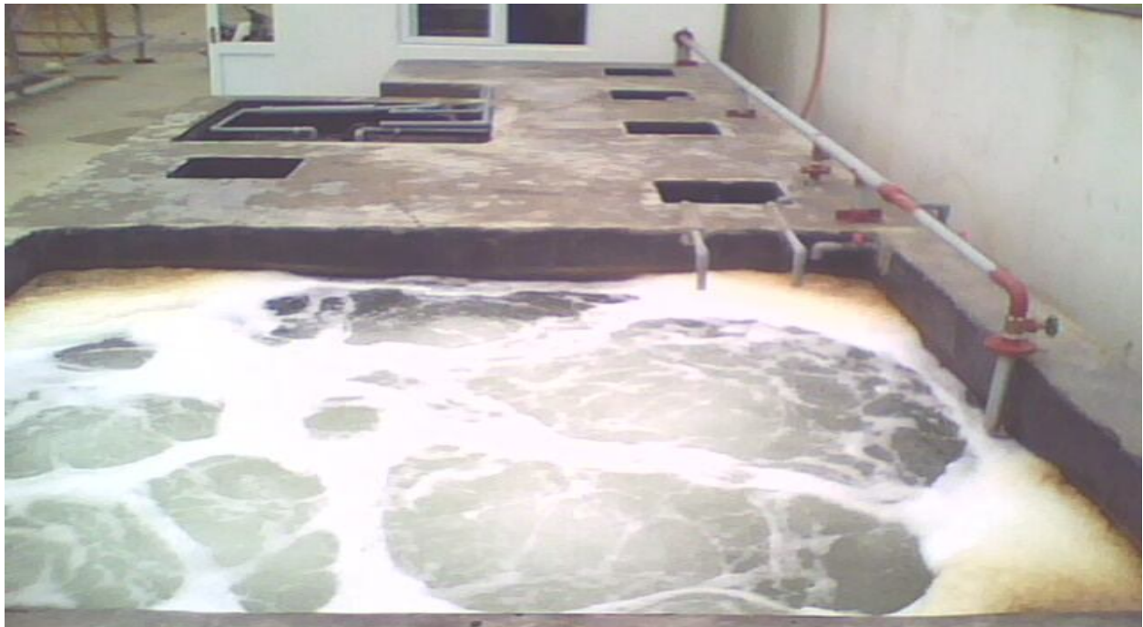
HỆ THỐNG XỬ LÝ NƯỚC THẢI 50M3 NHÀ MÁY DƯỢC HASAN – BÌNH DƯƠNG
