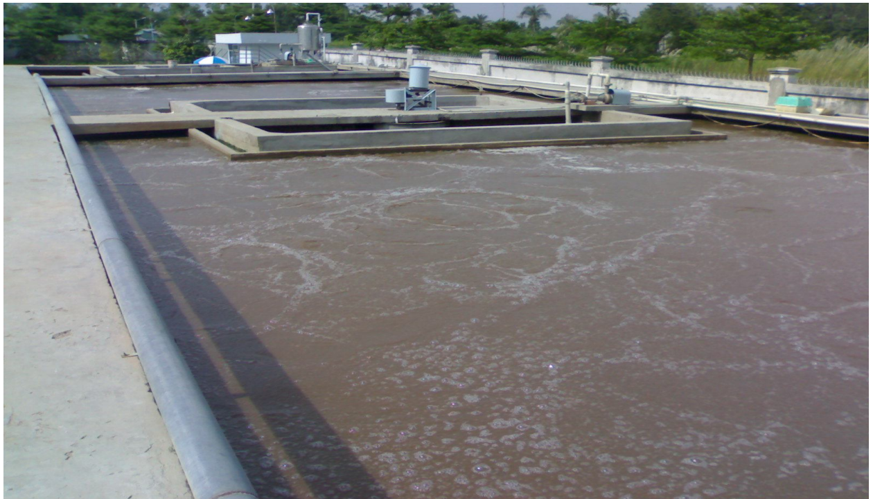
Trạm xử lý nước thải 600m 3 /ngày.đêm Công ty Cổ phần XNK Thủy sản An Mỹ - An Giang
