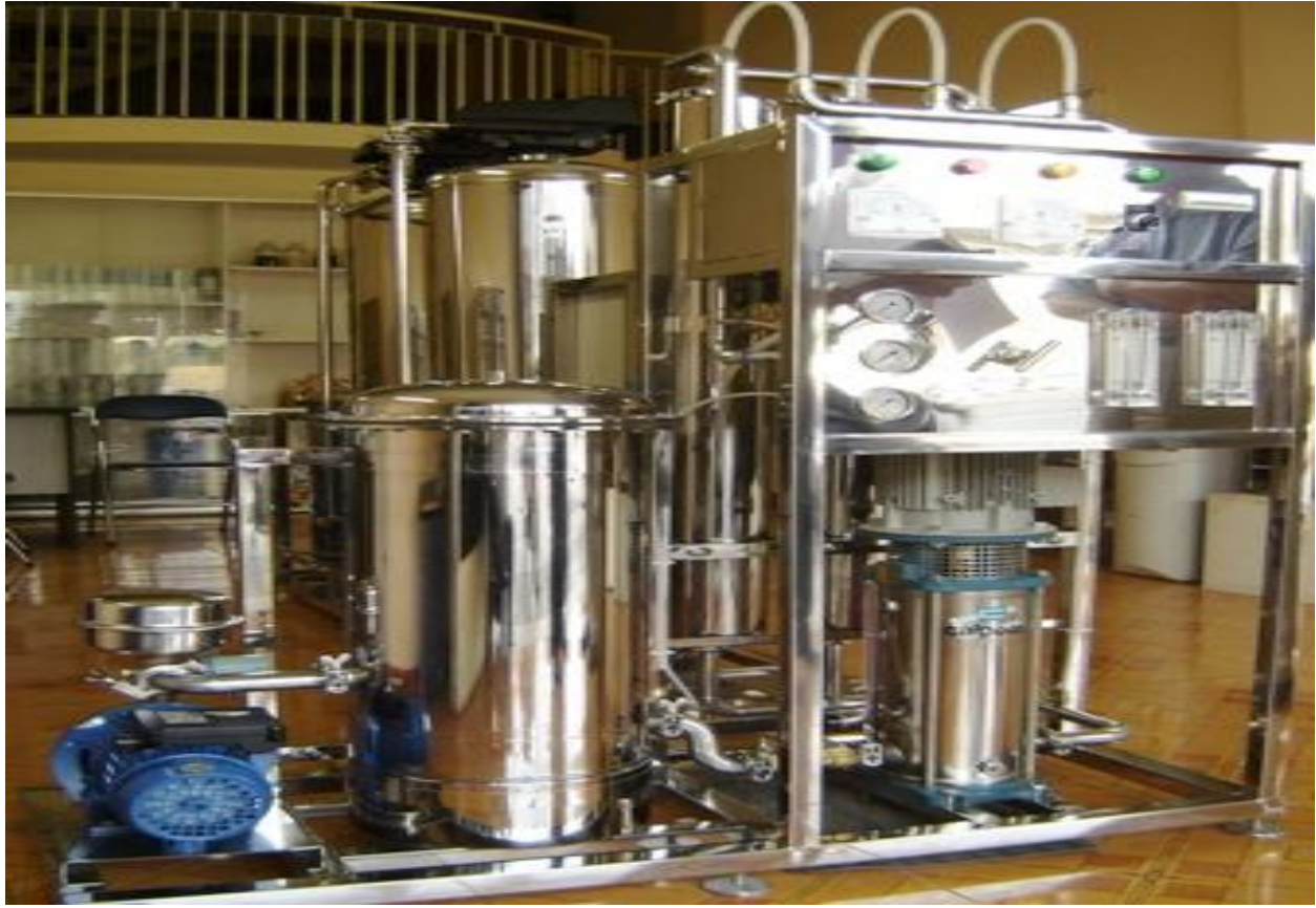
HỆ THỐNG XỬ LÝ NƯỚC RO 2M3H BỆNH VIỆN ĐA KHOA PHÚ YÊN
