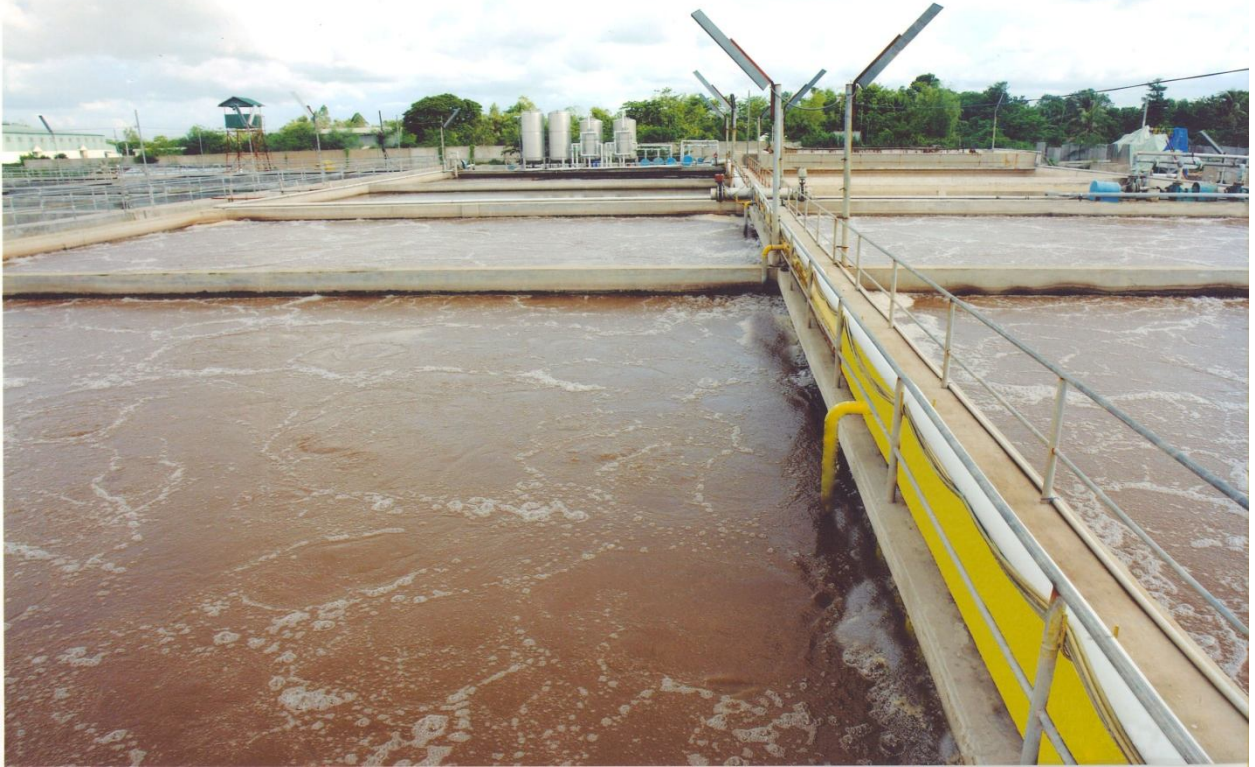
Trạm xử lý nước thải 3.000m 3 /ngày.đêm Công ty TNHH Đại Tây Dương – Cần Thơ
