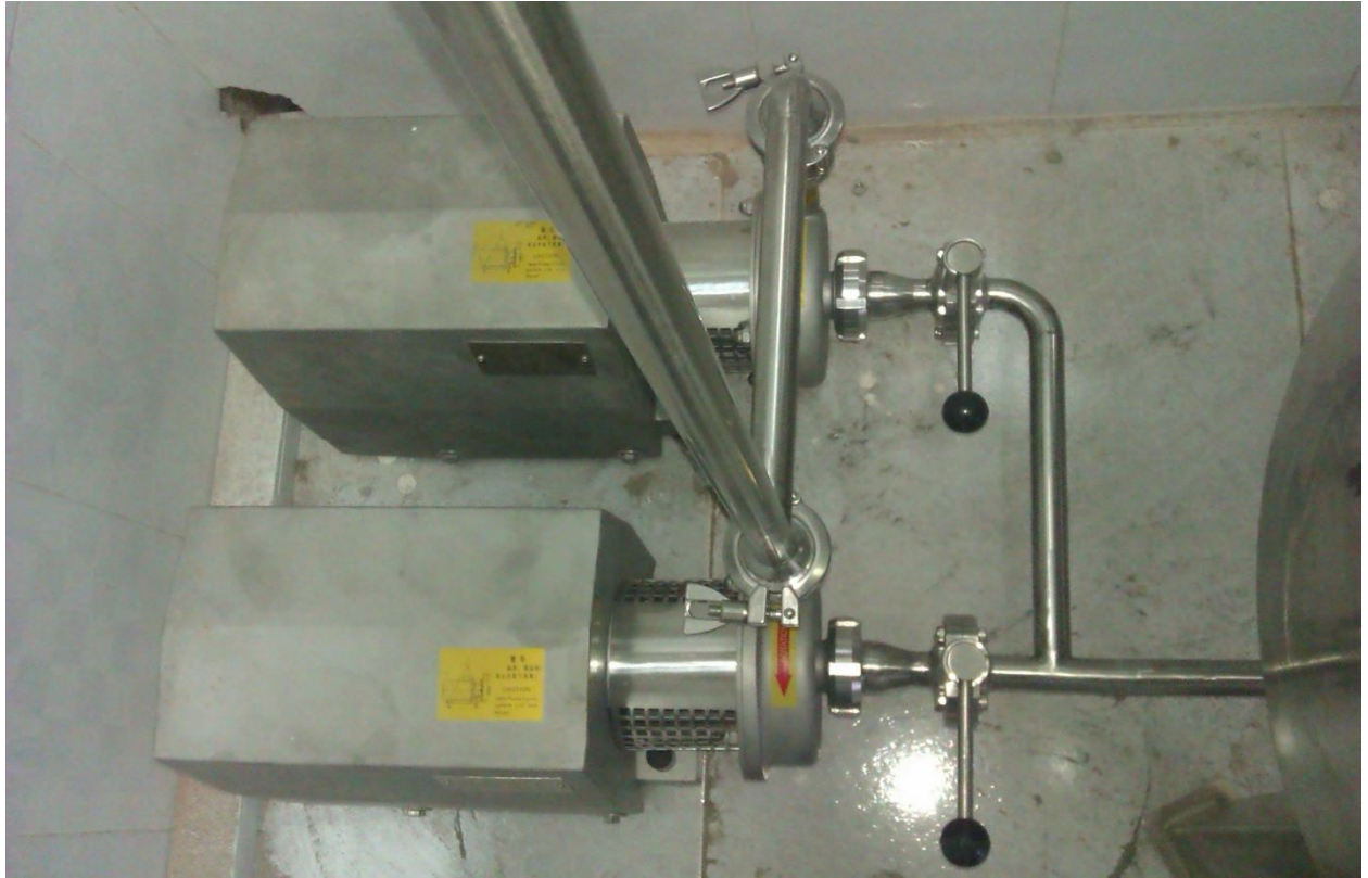
HỆ THỐNG BƠM 316L HOÀN LƯU NƯỚC CẮT CHO CÁC NHÀ MÁY
