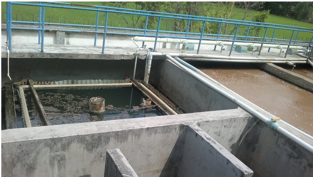
HỆ THỐNG XỬ LÝ NƯỚC THẢI 300M3 NHÀ MÁY NƯỚC TƯƠNG CỬ CHI
