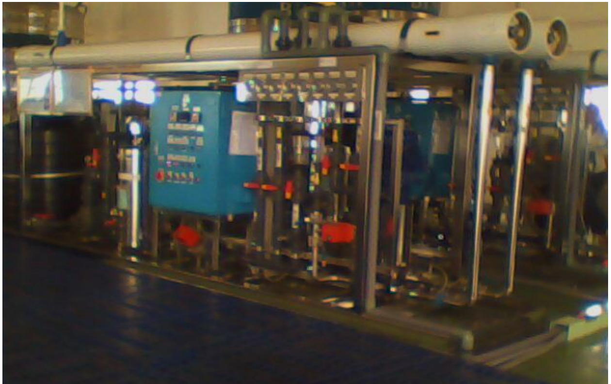
HỆ THỐNG XỬ LÝ NƯỚC RO TẠI NHÀ MÁY CÁ HỘP VIỆT CƯỜNG LONG AN
