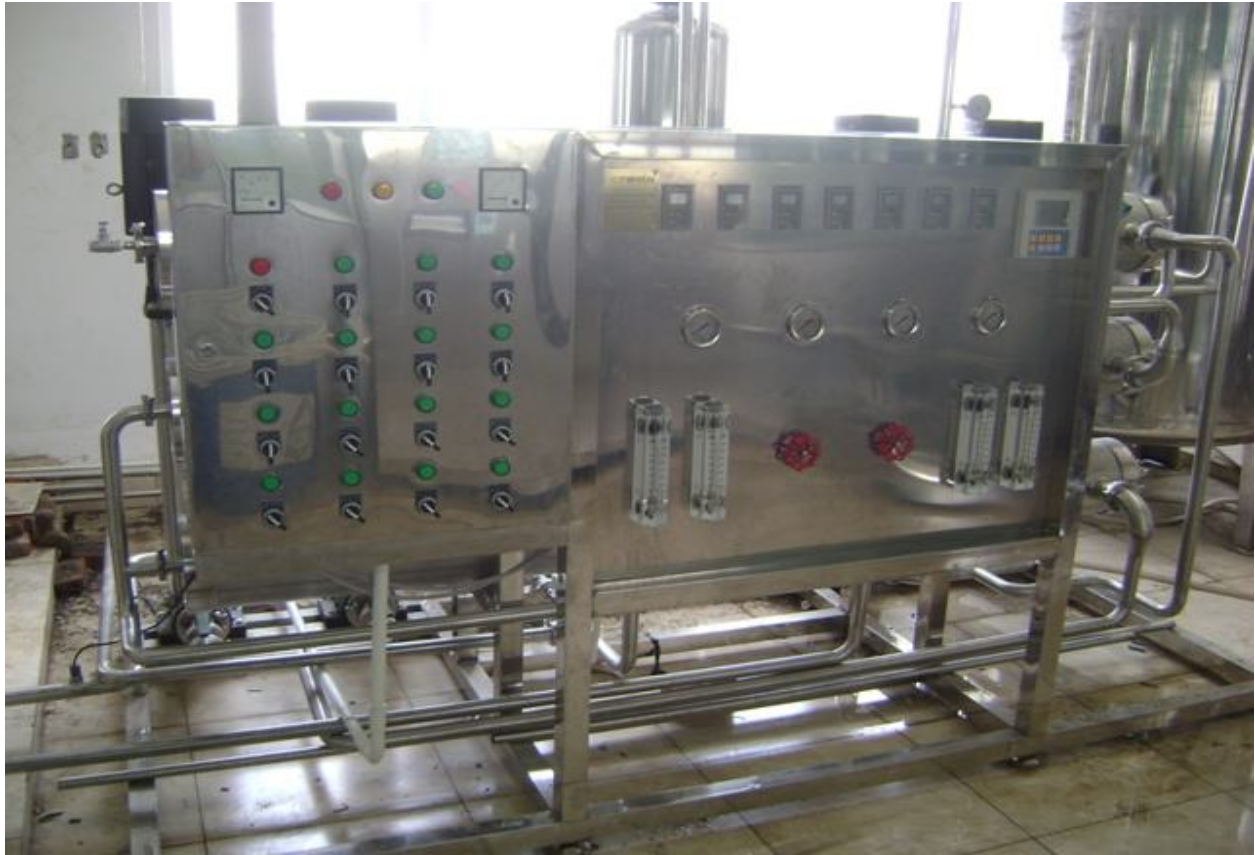
HỆ THỐNG XỬ LÝ NƯỚC RO 2 CẤP 3M3H NHÀ MÁY DƯỢC IMEXPHAMR BÌNH DƯƠNG
