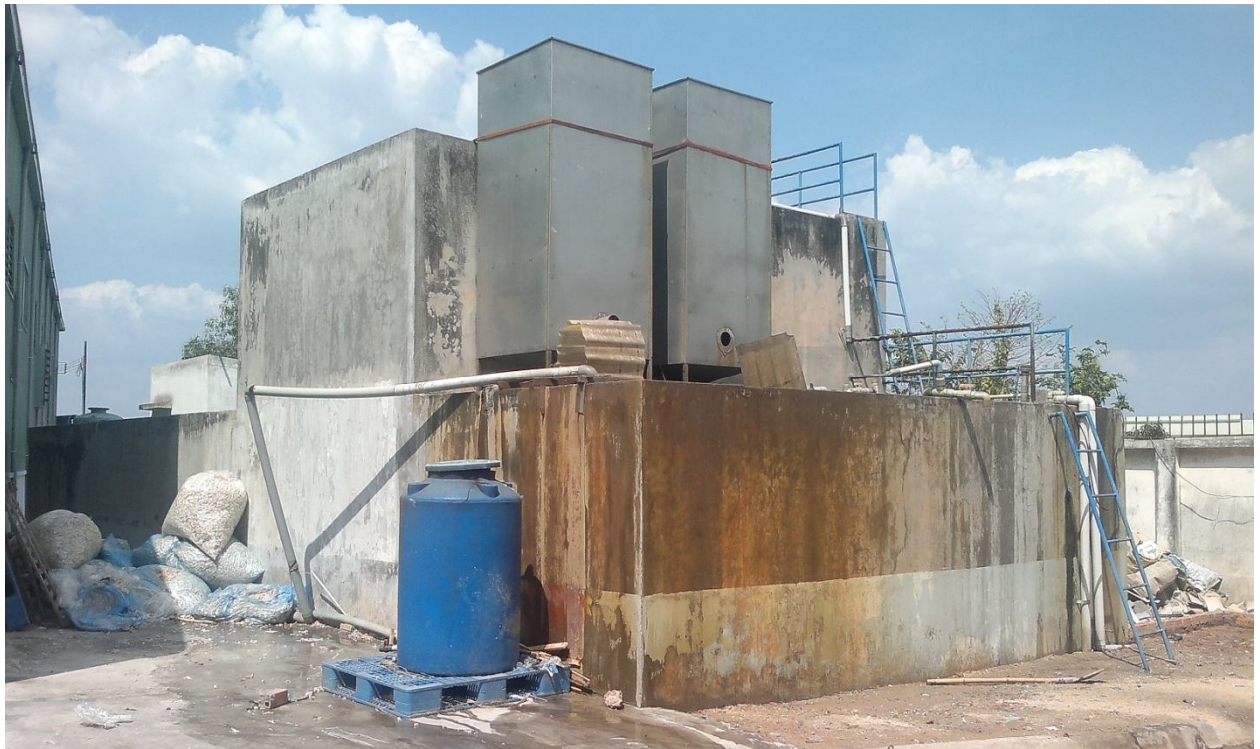
HỆ THỐNG XỬ LÝ NƯỚC THẢI 300M3 NHÀ MÁY NƯỚC TƯƠNG CỬ CHI
