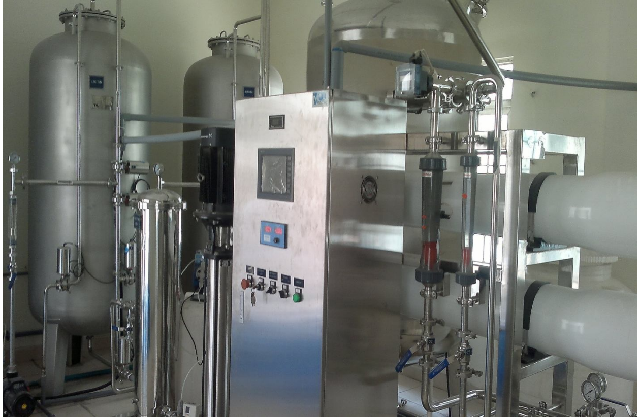
HỆ THỐNG XỬ LÝ NƯỚC RO VÀ EDI 3M3H NHÀ MÁY DƯỢC HASAN BÌNH DƯƠNG
