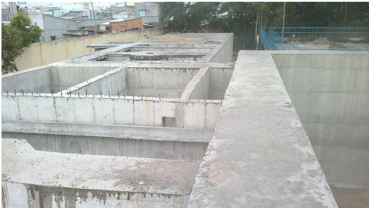
HỆ THỐNG XỬ LÝ NƯỚC THẢI 1200M 3 NHÀ MÁY THỦY SẢN TẬP TRUNG PHAN THIẾT
