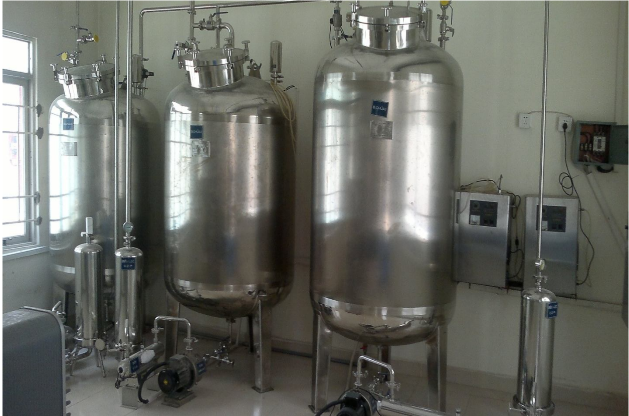
HỆ THỐNG XỬ LÝ NƯỚC RO VÀ EDI 3M3H NHÀ MÁY DƯỢC HASAN BÌNH DƯƠNG
