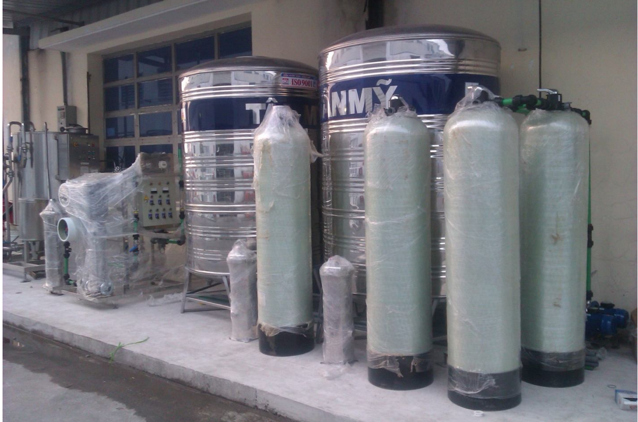
HỆ THỐNG RO TẠI NHÀ MÁY BÁNH KẸO KINH ĐÔ HƯNG YÊN
