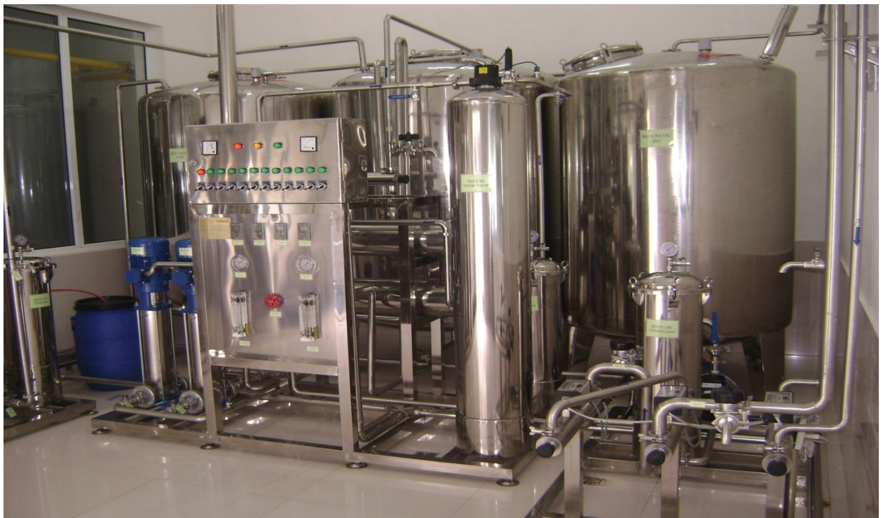
HỆ THỐNG XỬ LÝ NƯỚC RO 2M3H NHÀ MÁY DƯỢC LILI BẮC NINH
