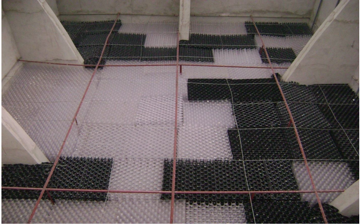
HỆ THỐNG GIÁ THỂ VI SINH BẨM TẠI NHÀ MÁY MAY NGA SƠN THANH HÓA
