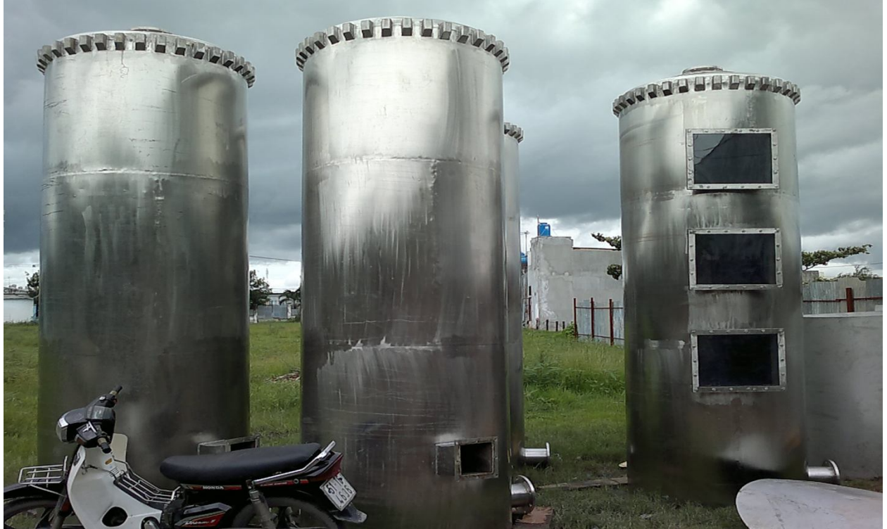
HỆ THỐNG XỬ LÝ KHÝ THẢI
