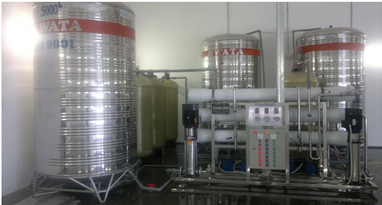
HỆ THỐNG XỬ LÝ NƯỚC RO 2 CẤP 4M3H JABIL VIỆT NAM KCNC Q9 TP HCM
