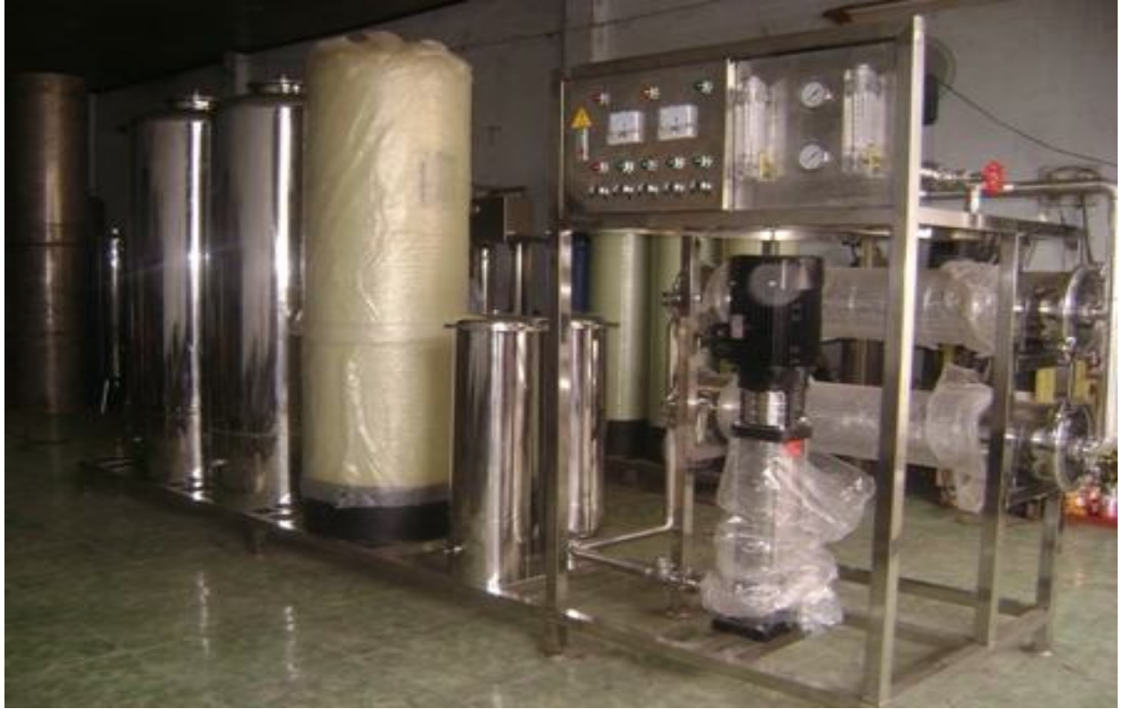
HỆ THỐNG XỬ LÝ NƯỚC RO NHÀ MÁY DƯỢC BV PHARMA CỬ CHI CS 2M3H
