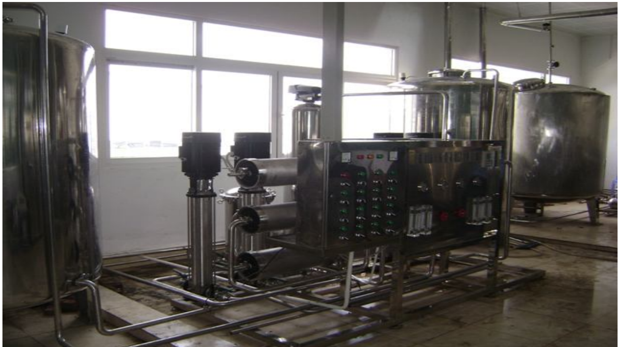
HỆ THỐNG XỬ LÝ NƯỚC RO 2 CẤP 3M3H NHÀ MÁY DƯỢC IMEXPHAMR BÌNH DƯƠNG
