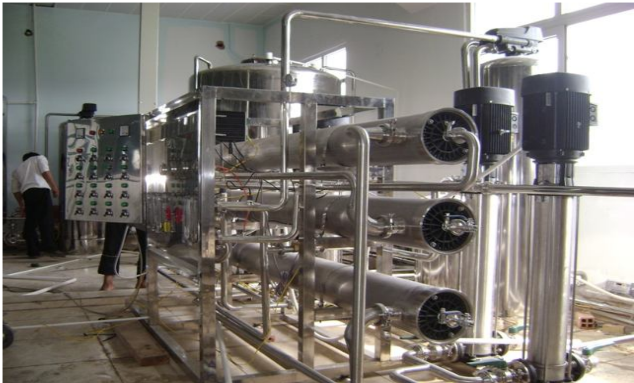
HỆ THỐNG XỬ LÝ NƯỚC RO 2 CẤP 3M3H NHÀ MÁY DƯỢC IMEXPHAMR BÌNH DƯƠNG
