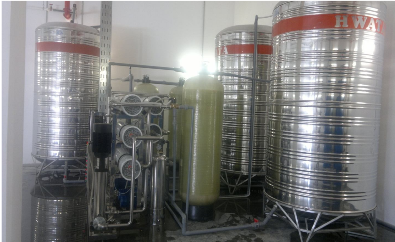
HỆ THỐNG XỬ LÝ NƯỚC RO 2 CẤP 4M3H JABIL VIỆT NAM KCNC Q9 TP HCM
