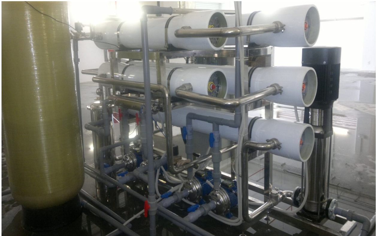
HỆ THỐNG XỬ LÝ NƯỚC RO 2 CẤP 4M3H JABIL VIỆT NAM KCNC Q9 TP HCM
