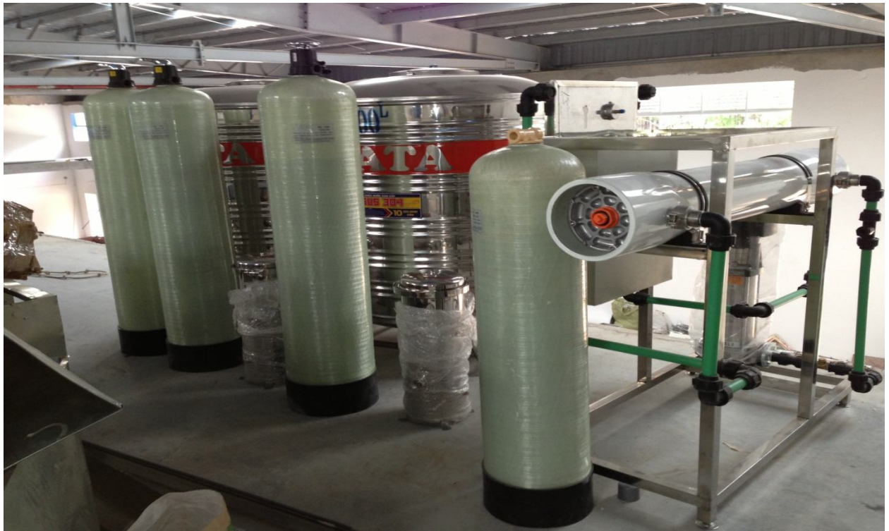
HỆ THỐNG RO TẠI NHÀ MÁY DƯỢC THÚ Y AFTA BÌNH DƯƠNG
