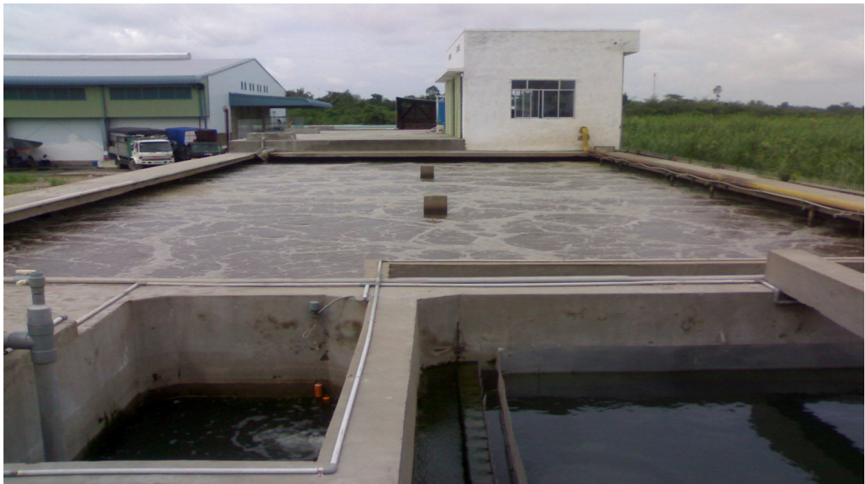
Trạm xử lý nước thải 800m 3 /ngày.đêm Công ty CP XNK Thủy sản Cửu Long – An Giang
