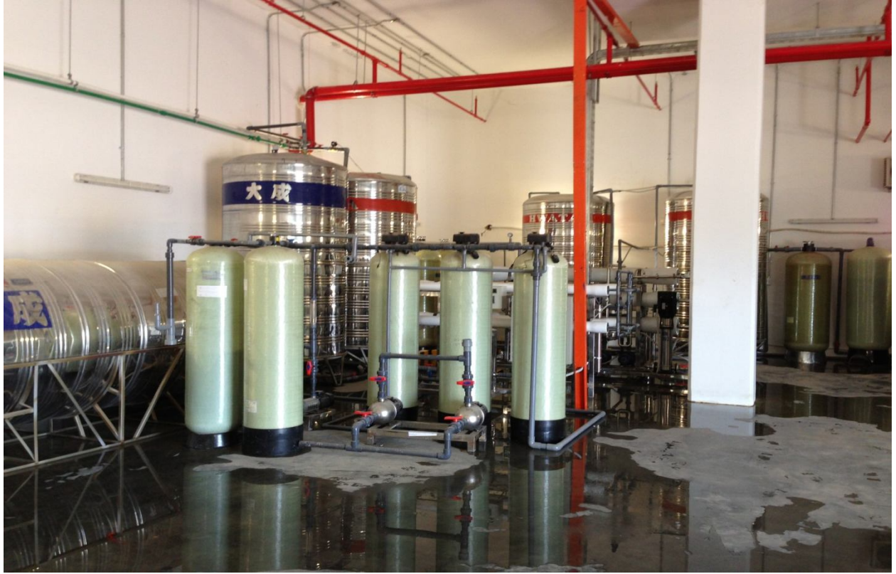
HỆ THỐNG XỬ LÝ NƯỚC RO 2 CẤP LÀM ĐIỆN TỬ QUẬN 9 TP HCM
