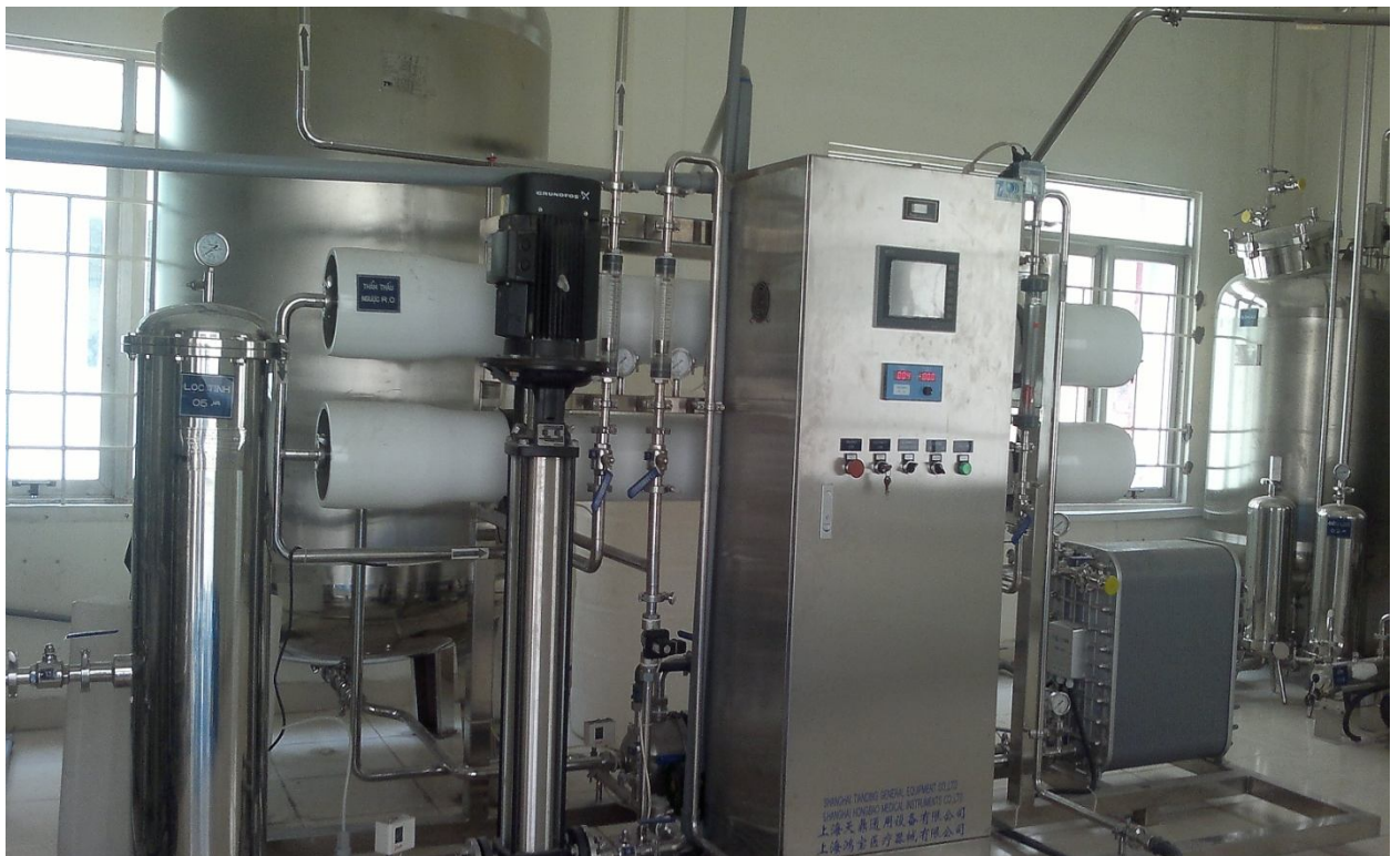
HỆ THỐNG XỬ LÝ NƯỚC RO VÀ EDI 3M3H NHÀ MÁY DƯỢC HASAN BÌNH DƯƠNG
