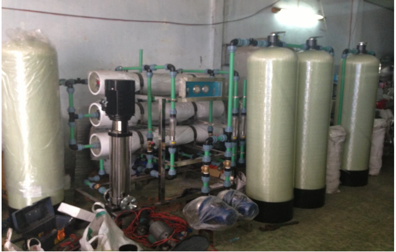
HỆ THỐNG XỬ LÝ NƯỚC RO 2 CẤP NHÀ MÁY DƯỢC QUẾ LÂM HÀ NỘI
