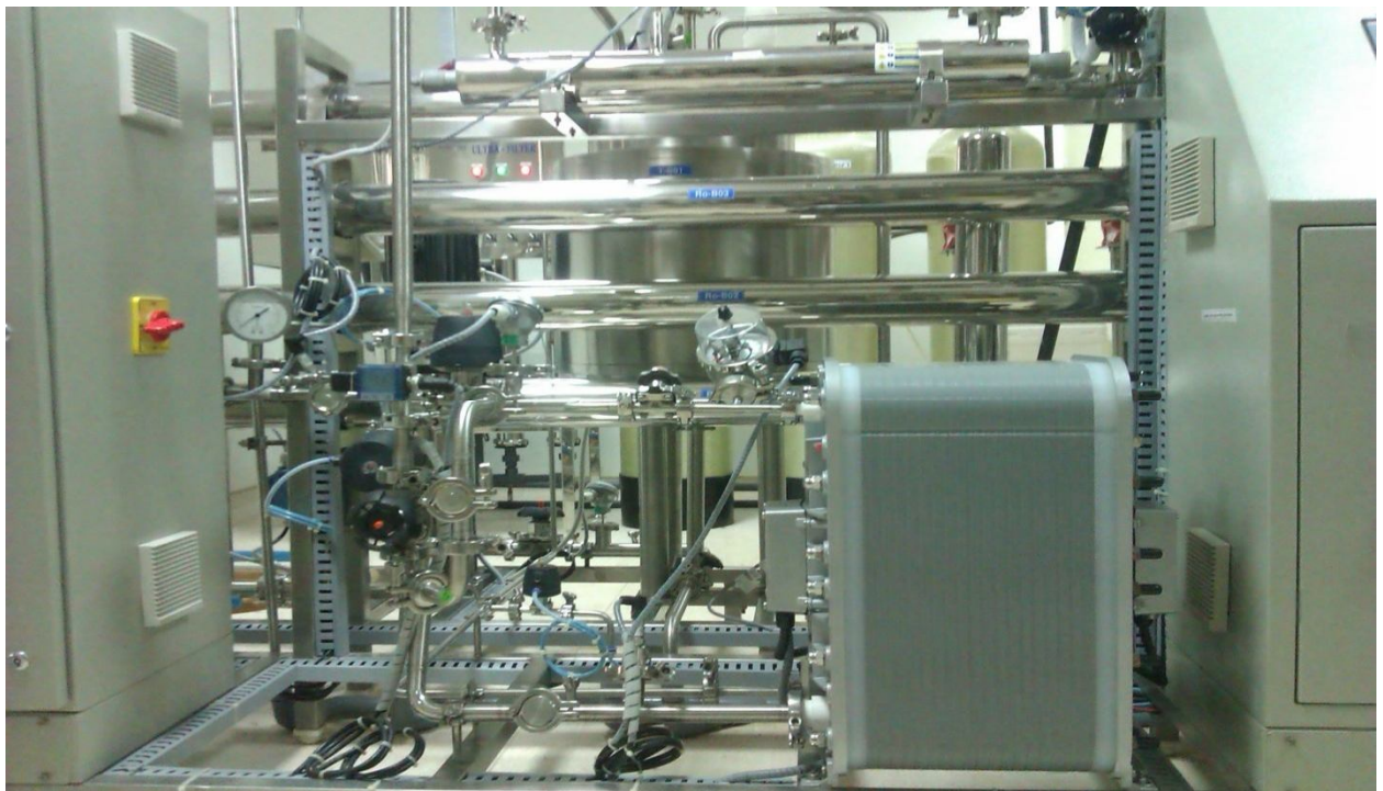
HỆ THỐNG XỬ LÝ NƯỚC RO VÀ EDI 2,5M3H NHÀ MÁY DƯỢC BOST VISIP BÌNH DƯƠNG
