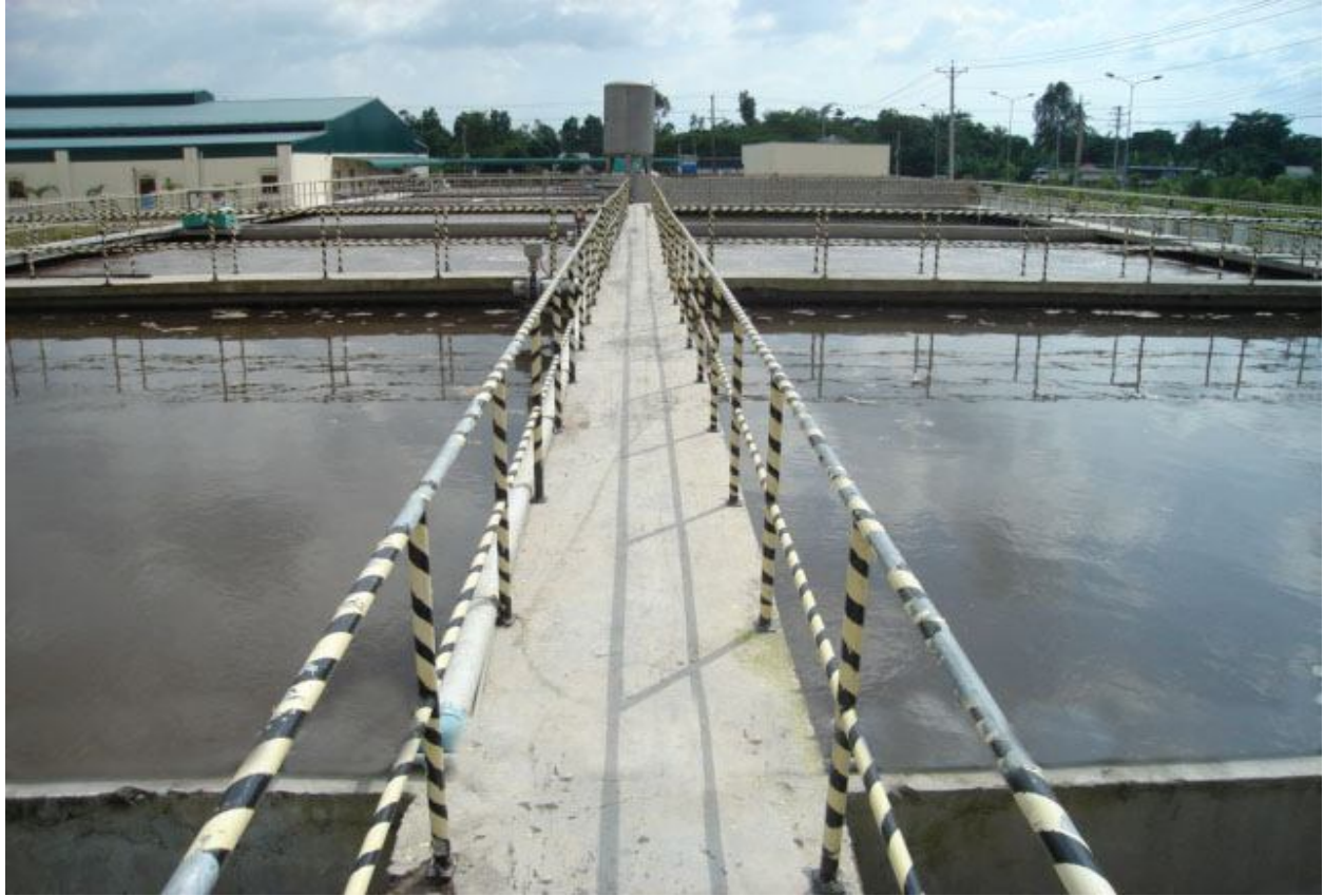
Trạm xử lý nước thải 1.600m 3 /ngày.đêm Công ty CP Thủy sản Trường Giang – Đồng Tháp
